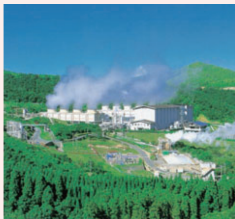
八丁原発電所
