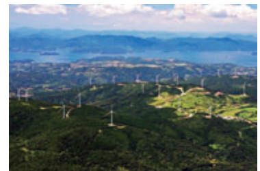
長島ウインドヒル(株) 長島風力発電所
