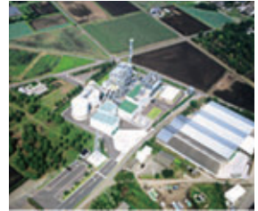
みやざきバイオマスリサイクル(株) みやざきバイオマスリサイクル発電所
