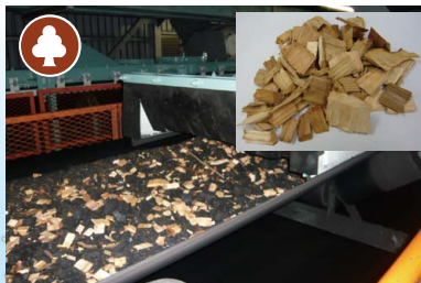
苓北発電所石炭と混ぜられた木質チップ(粉碎前)
