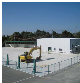
再生骨材製造プラント
