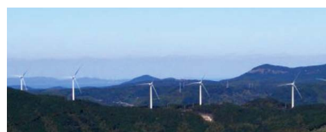
鷲尾岳風力発電所（グループ会社の鷲尾岳風力発電(株)）
