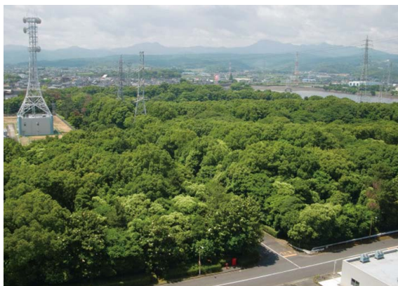
発電所構内緑地の様子(豊前発電所)
