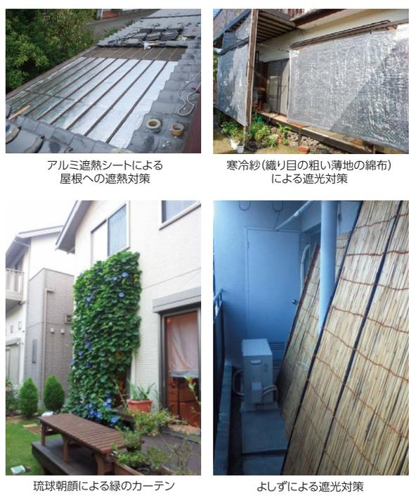
アルミ遮熱シートによる屋根への遮熱対策
