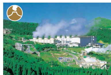
八丁原発電所
