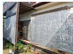
寒冷紗(織り目の粗い薄地の綿布)による遮光対策
