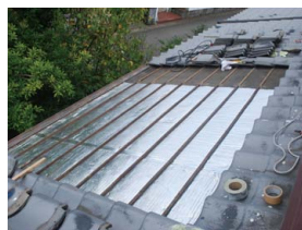
アルミ遮熱シートによる屋根への遮熱対策
