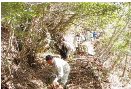
用水路浚渫作業の様子
