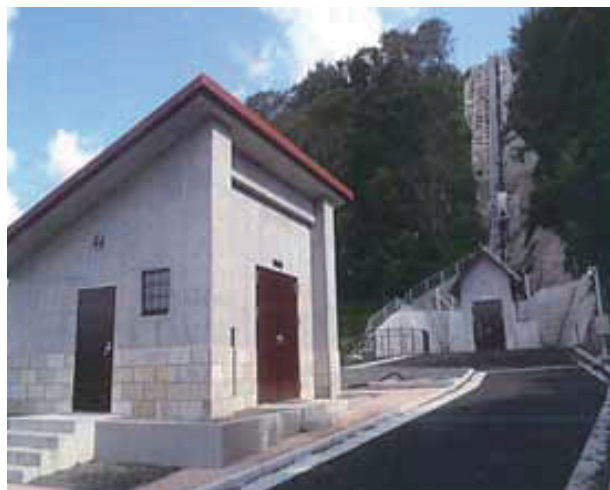
西技工業(株) 龍門滝発電所 (奥は落差約50mの水圧鉄管)
