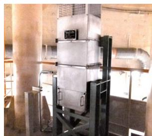
(※1) 冷却水による熱交換で、格納容器内の空気を冷却する装置 (※2) 触媒により、水素と酸素を反応させて水にする装置 (※3) 電気ヒータにより、水素を強制的に燃焼させて水にする装置
