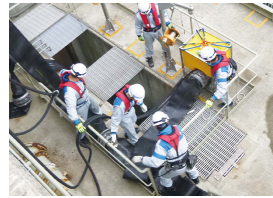
◇海水取水する水中ポンプの設置
