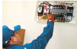
分電盤の点検
