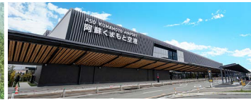
熊本空港新旅客ターミナルビル (2023年3月開業)
