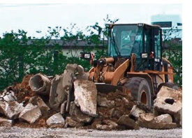
◇重機によるがれき撤去
