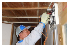
屋内配線診断（熊本配電事業所）
