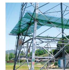
送電鉄塔の昇塔防止装置の設置
