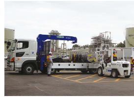
◇電源ケーブルの運搬
