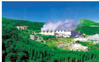
八丁原発電所
