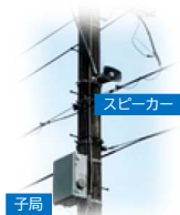
電柱への設置状況
