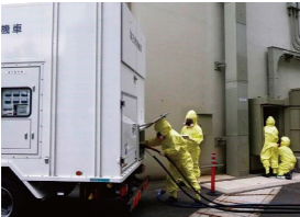
高圧発電機車の電源ケーブル接続
