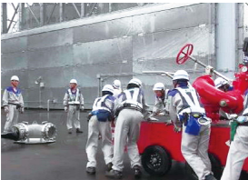
放水砲の設置
