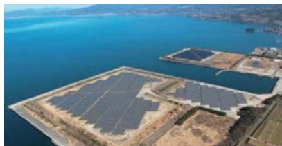
大村メガソーラー発電所
