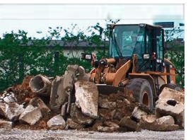
重機によるがれき撤去
