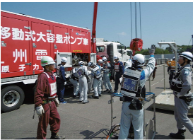
移動式大容量ポンプ車の設置
