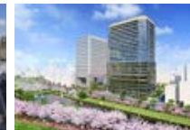
福岡家庭裁判所跡地活用事業 (2029年度竣工予定)
