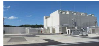
緊急時対策棟(川内)
