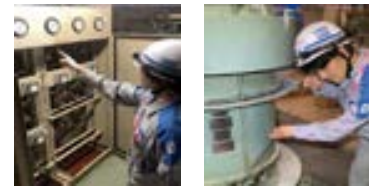
指差呼称による計器の確認
