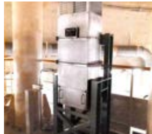
静的触媒式水素再結合装置
