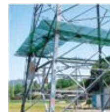
送電鉄塔の昇塔防止装置の設置
