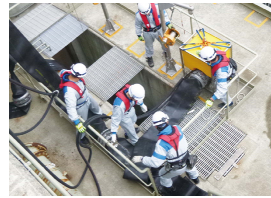
海水を取り水する水中ポンプの設置
