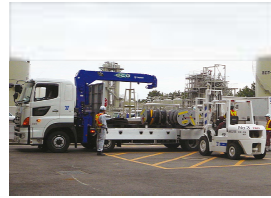
電源ケーブルの運搬
