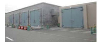
資機材等を収納する保管庫(玄海)
