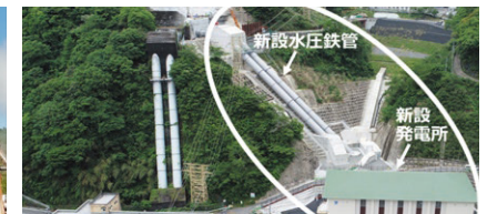
塚原水力発電所のリプレース工事
