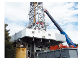
地熱発電所の新規開発地点資源調査 (左：資源確認のための掘削、右：蒸気等能力確認試験)
