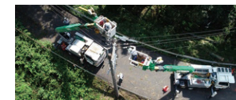
復旧作業の様子
