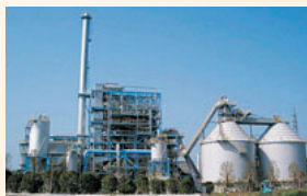
完成した鶏ふん焼却発電施設
