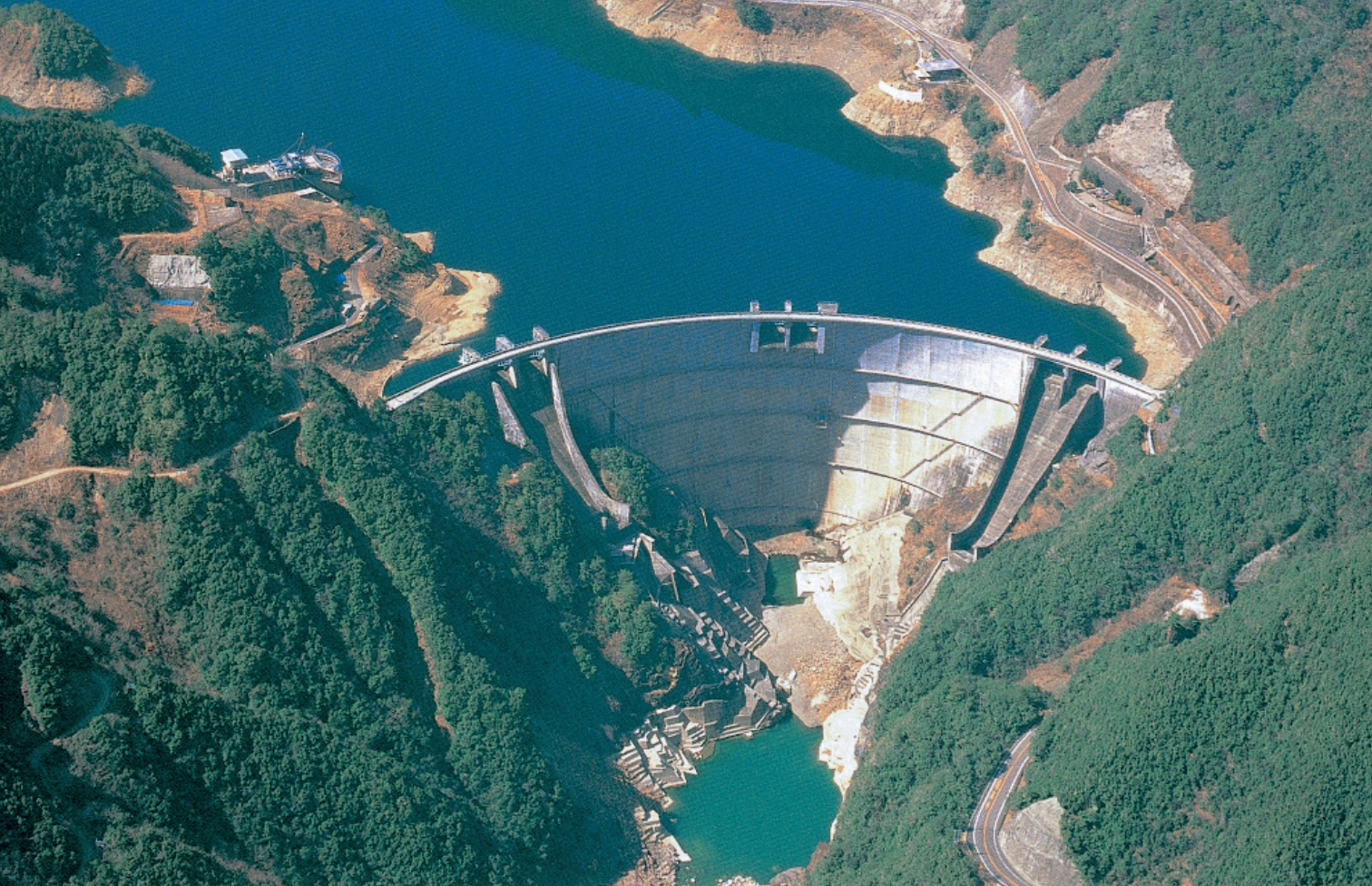
一ツ瀬発電所（宮崎県西都市）
