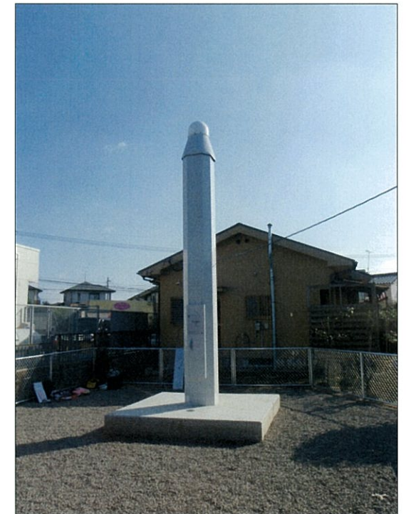
吉野町の機器設置状況
