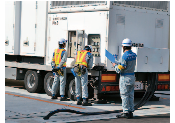
移動式大容量発電機を使った電源確保訓練を実施
