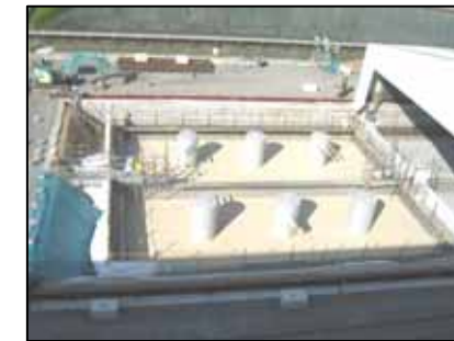
非常用ディーゼル発電機 燃料油貯蔵タンク増設工事
