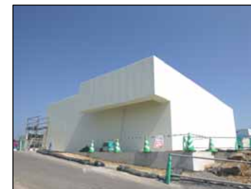
緊急時対策所設置工事 【平成25年10月完成予定】
