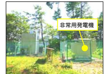
モニタリングポスト用 非常用発電機設置
