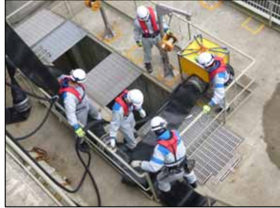
可搬型ポンプによる原子炉冷却のための給水源を確保
