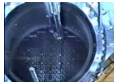
原子炉への燃料装荷
