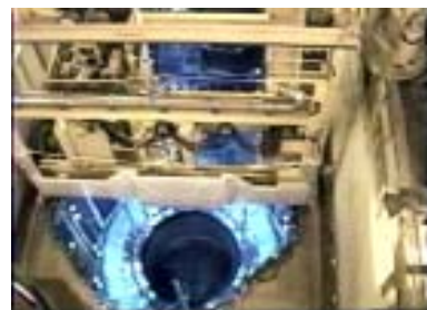
燃料取扱クレーンでの燃料装荷
