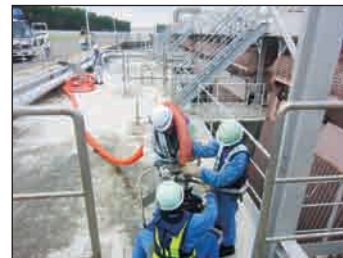
◇仮設ポンプより海水を取水
