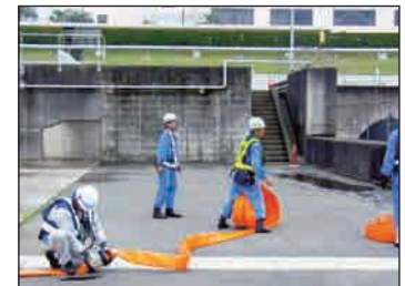
◇仮設ホースの敷設
