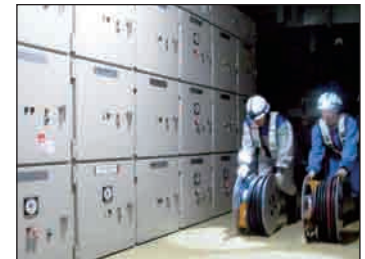
◇電源ケーブル敷設
