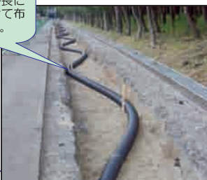
◇移動式大容量発電機からの電源ケーブル布設工事状況
