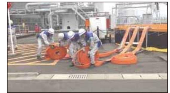
原子炉冷却用の可搬型ディーゼル注入ポンプや仮設ホースの設置
