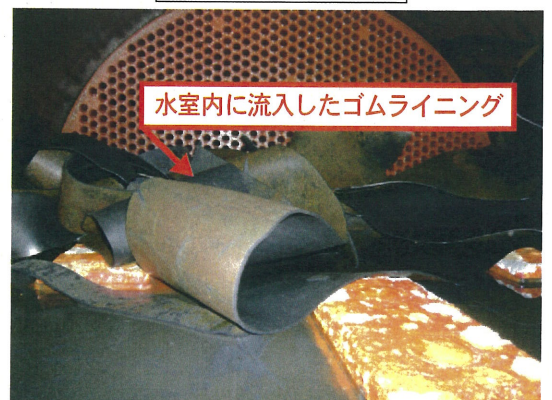
入口側水室内部
