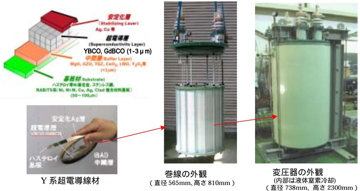
図 1 Y系小型超電導変圧器(400kVA)
