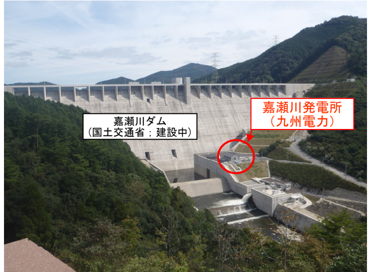
[嘉瀬川ダム・発電所の状況]
