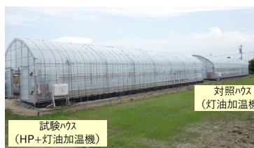
図1 実証ハウス（外観）
