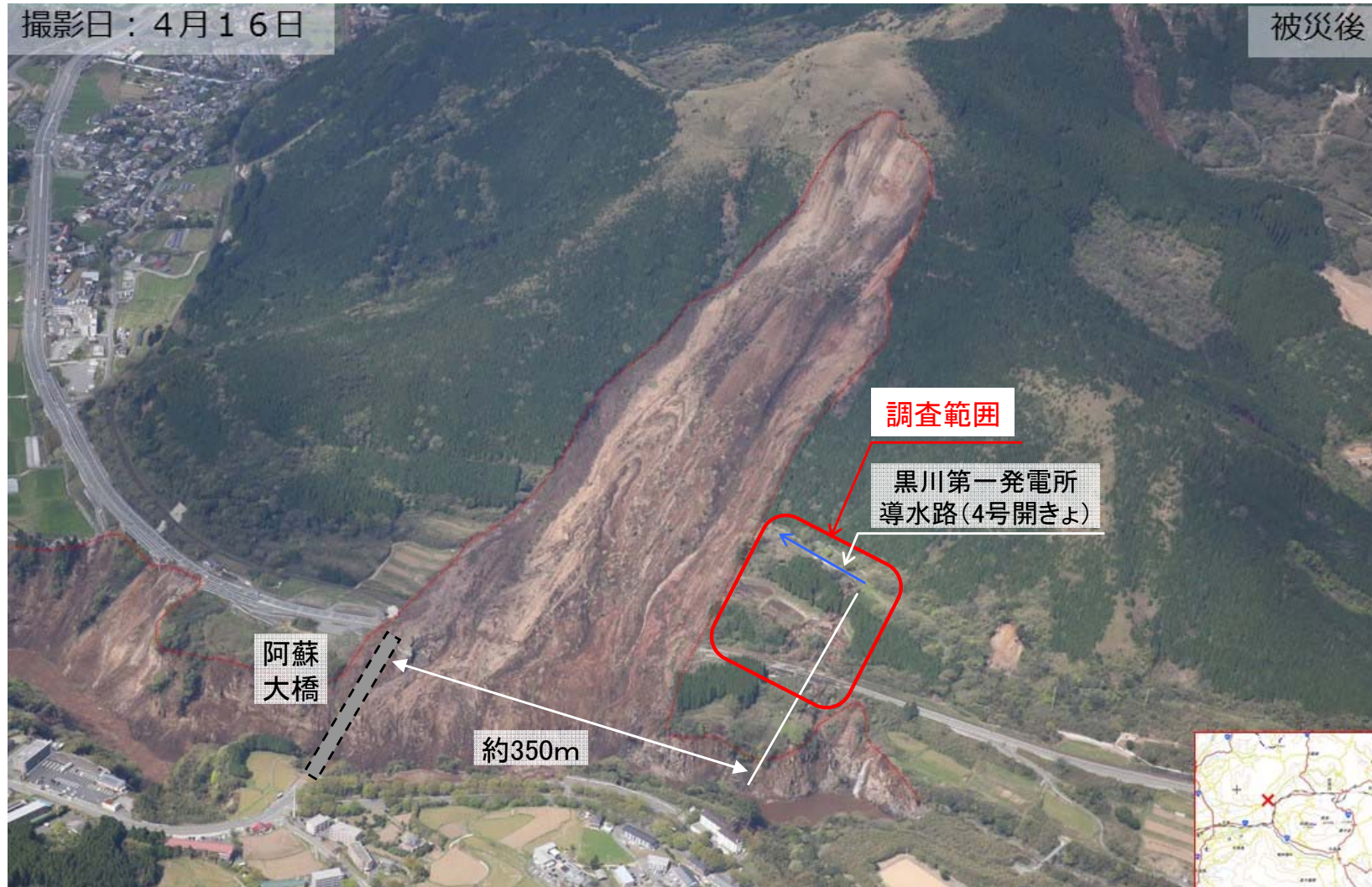
「平成28年熊本地震に伴う被害状況【阿蘇大橋周辺】」(国土地理院ホームページ)を加工して作成
