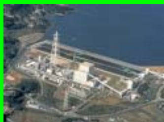
松浦発電所 (70 万 kW, 石炭火力)
