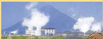
●地下約2000mから高温の水蒸気を取り出し、約1万戸のお家の電気を作り出しているんだよ!
