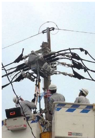
開閉器の現場修理
