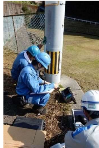
金属柱の超音波点検
