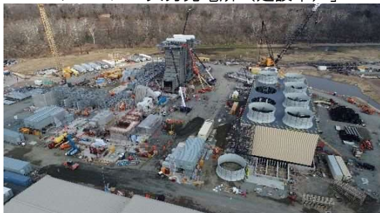
[バーズボローガス火力発電所（建設中）]
