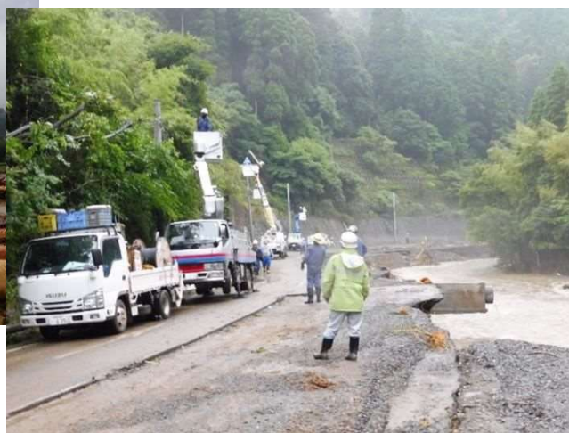
配電線被害の復旧作業
