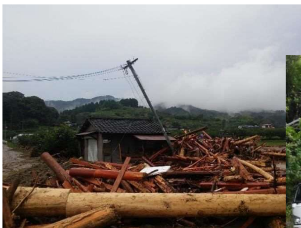
流倒木による配電線被害
