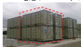
N A S 電池サブユニット (800kW×63台)
