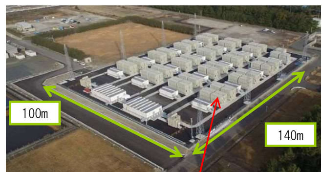
N A S 電池サブユニット (800kW×63台)
