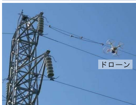
送電線の設備確認状況
