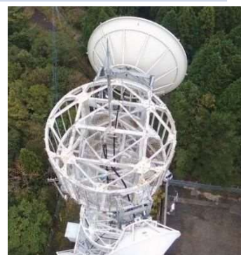
通信無線鉄塔の巡視状況
