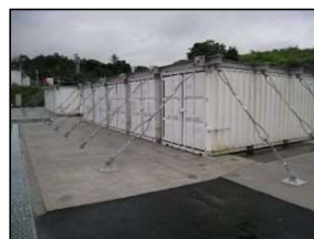
資材保管用コンテナの固縛 （竜巻対策）
