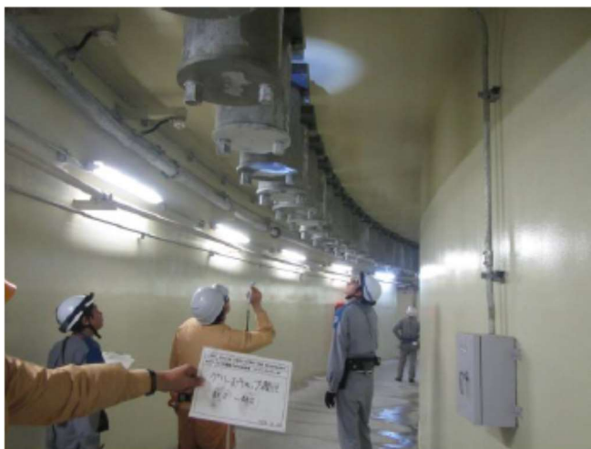
プレストレストコンクリート製格納容器の点検
