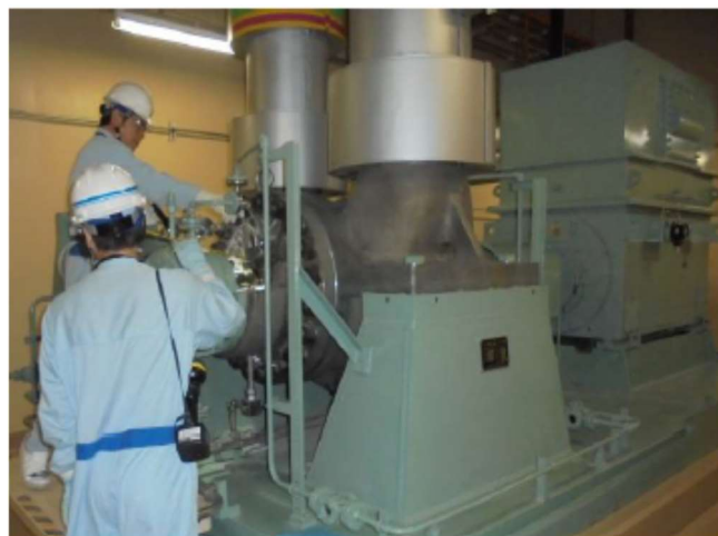
格納容器スプレイポンプ作動試験
