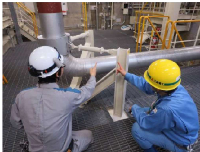
配管支持構造物の点検
