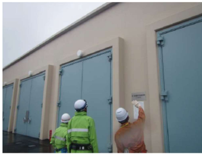
重大事故等対処設備保管庫の点検
