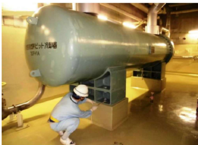
基礎ボルトの点検
