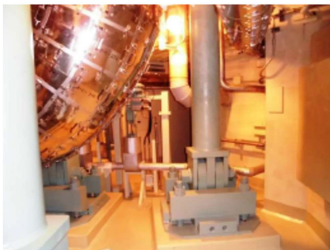
原子炉圧力容器（支持構造物）の点検
