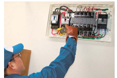
分電盤の点検
