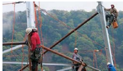
平成28年熊本地震における仮鉄塔建設作業
