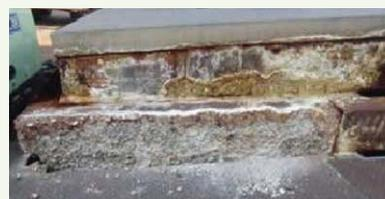
コンクリート構造物の酸性劣化状況【補修前】
