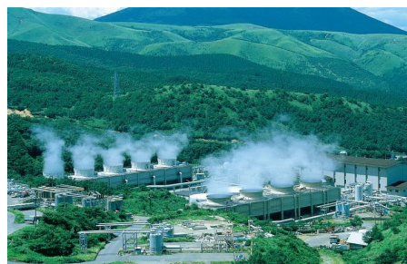
〈八丁原地熱発電所〉
