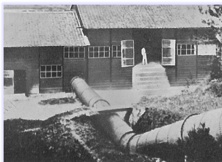
(建設当初※現在建物は建替え済み)
