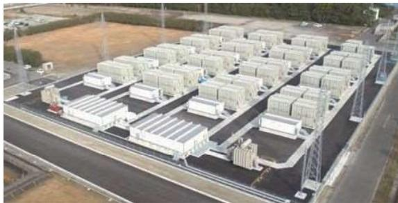
豊前蓄電池変電所 (2016年設置、出力5万kW・容量30万kWh)
