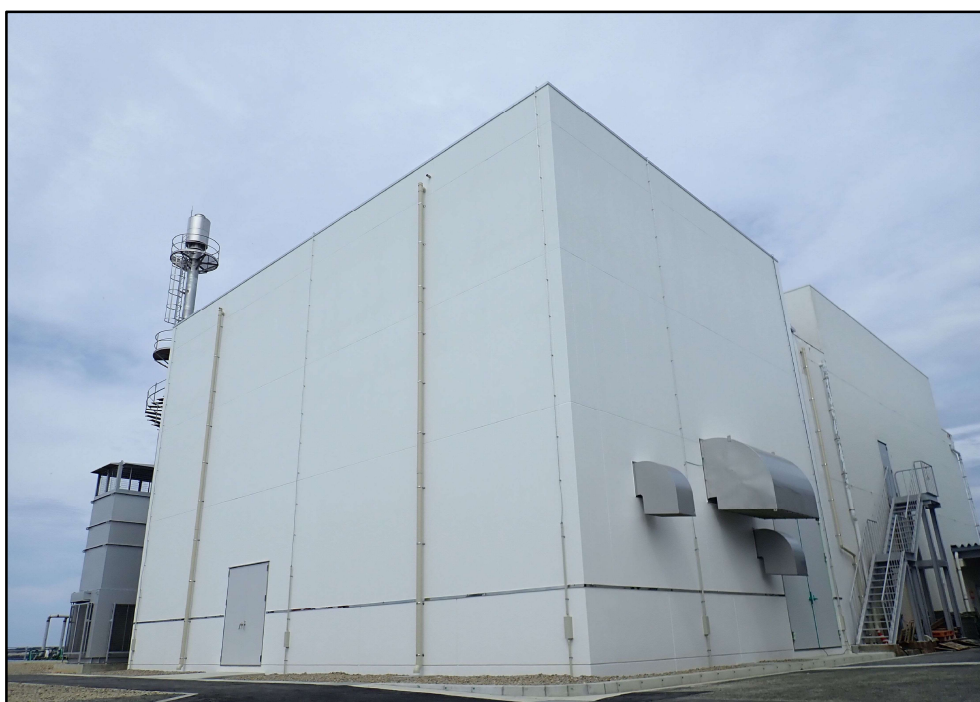
4号機建屋外観
