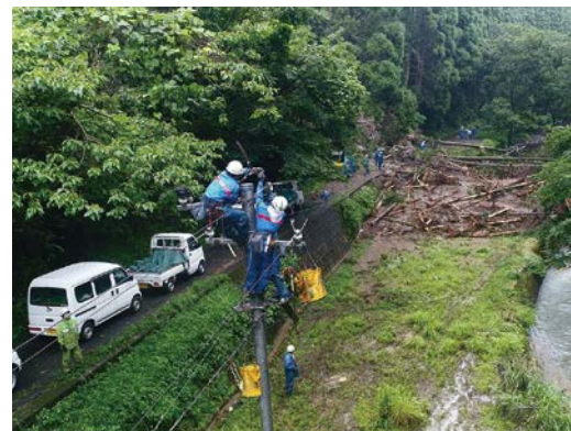
土砂崩れによる電柱流出に伴う配電線路復旧
