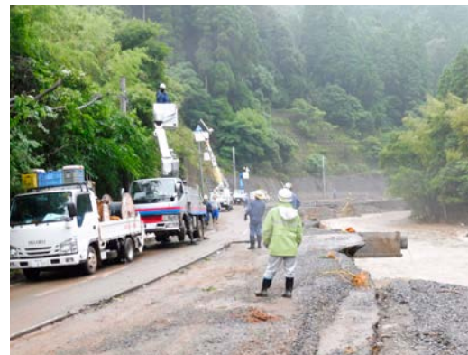
配電線路の新設
