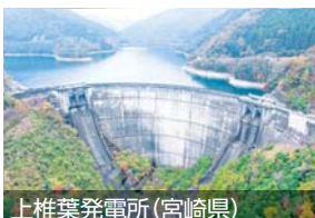
上椎葉発電所(宮崎県)
