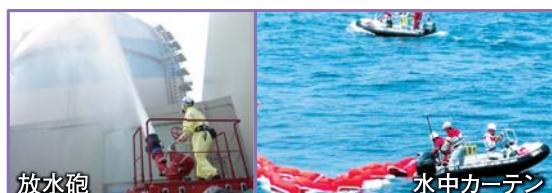
原子炉格納容器の破損箇所に水を直接噴射し、放射性物質の放出を抑制する放水砲
