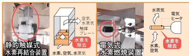
原子炉格納容器内の水素爆発を防ぐ水素除去装置
