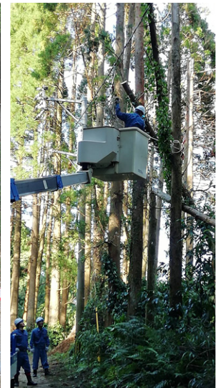
倒木除去作業
