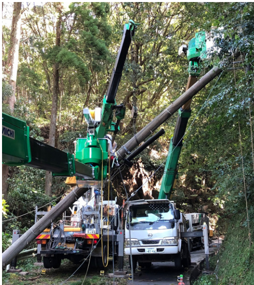
電柱折損復旧対応
