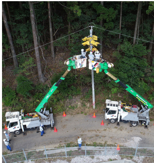
配電線路復旧
