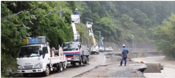
配電線路の新設
