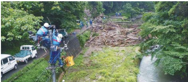
土砂崩れによる電柱流出に伴う配電線路復旧
