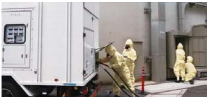
高圧発電機車の電源ケーブル接続
