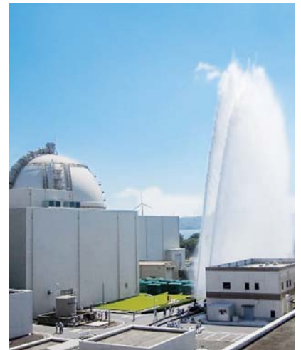
放水砲による放水
