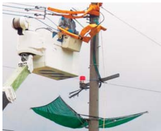
落下防止ネット
