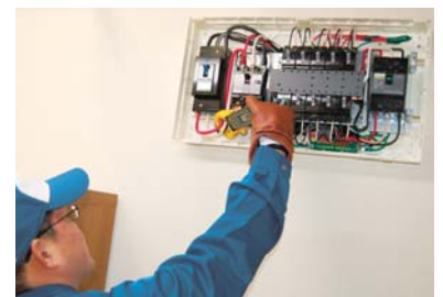
分電盤の点検
