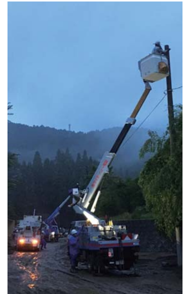
夜間における配電線路復旧
