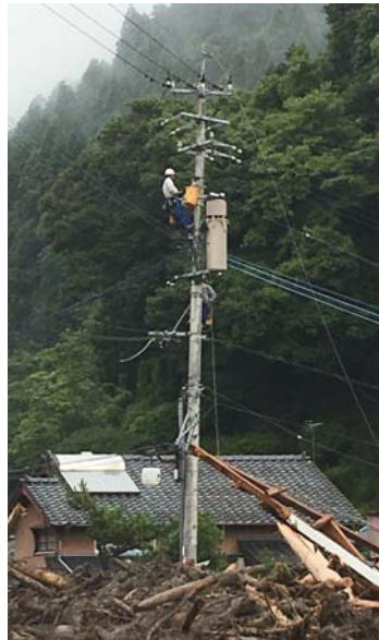
進入困難地区での配電線路復旧
