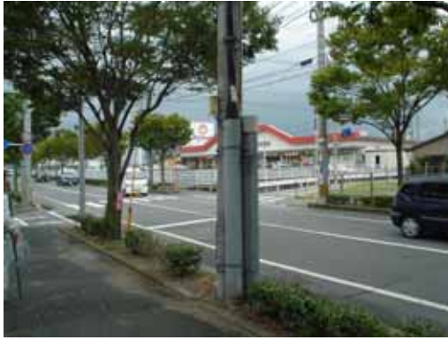
写真5 ケーブルの立ち上がり部
