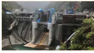
耳川水系で2番目に古いダム(S7運開) 現在、改造工事中(R4.5末運開予定) ラジアルゲートでは日本最大の面積
