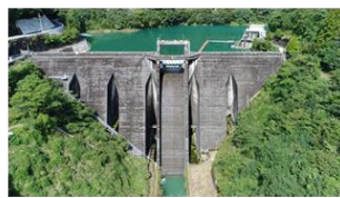
九州唯一(全国で13基のみ)の 中空重力式ダム
