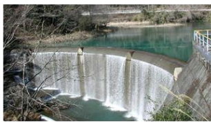
日本で2番目に小さいアーチ式ダム
