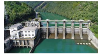
九州初のダム式発電所である大内原 発電所のダム
