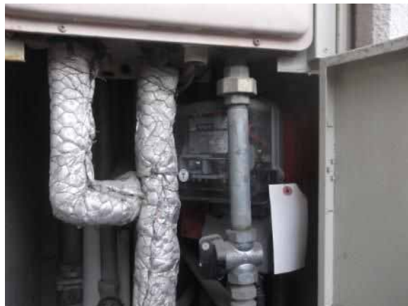
計器正面・側面に配管（計器のカバー取り外しや計器取替作業のスペースがない）
