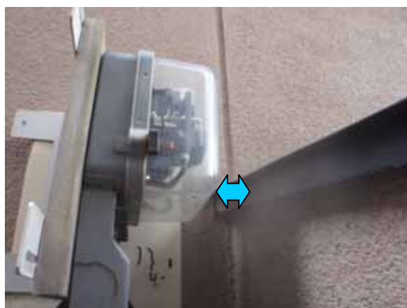
計器正面に軒先・屋根（計器のカバーを取り外すスペースがない）
