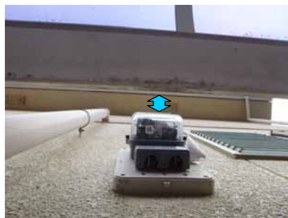
計器正面にカーポートフレーム（計器のカバーを取り外すスペースがない）
