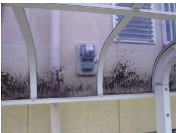
計器正面にカーポートフレーム（計器のカバーを取り外すスペースがない）
