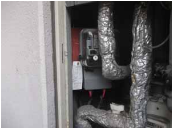
計器正面・側面に配管（計器のカバー取り外しや計器取替作業のスペースがない）
