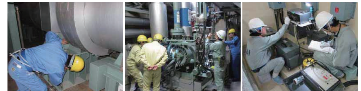
配管の支持装置点検
