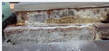
コンクリート構造物の酸性劣化状況【補修前】
