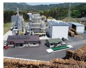
▲ふくおか木質バイオマス発電所
