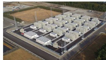
▲ 豊前蓄電池変電所
