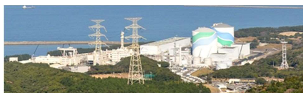
▼ 川内原子力発電所
