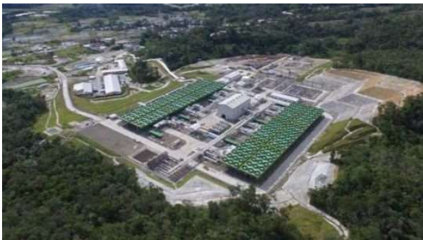
▲ サルラ地熱発電所(インドネシア)
