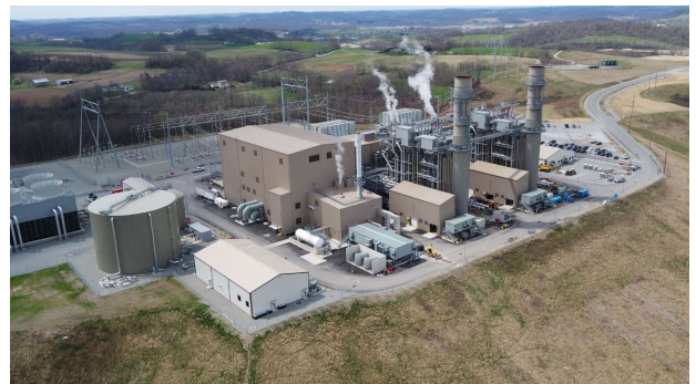
▲ ウェストモアランド ガス火力発電所(アメリカ)
