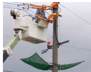
配電工事中の落下防止ネット使用
