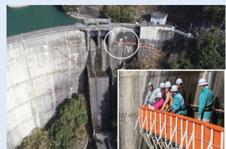
宮崎県上椎葉ダム点検通路歩行体験
