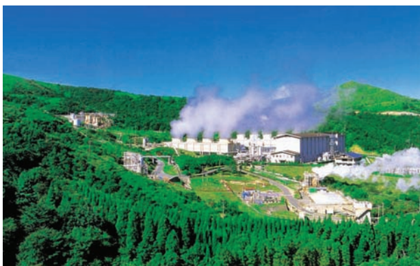
八丁原発電所
