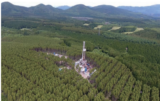
山下池南部地域調査井掘削状況
