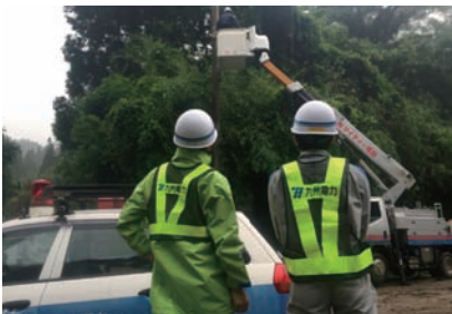
九州北部豪雨復旧作業
