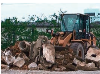
◇重機によるがれき撤去
