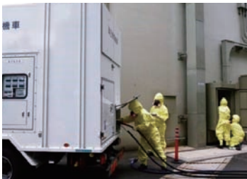
◇高圧発電機車の電源ケーブル接続
