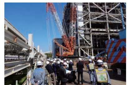
松浦2号機増設工事現場公開
