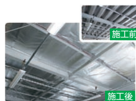
夏場ピーク時の屋根からの熱量を約9割カット 「遮熱シート(トップヒートバリアー)」(九電テクノシステムズ株)
