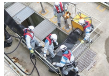
◇海水を取水する水中ポンプの設置
