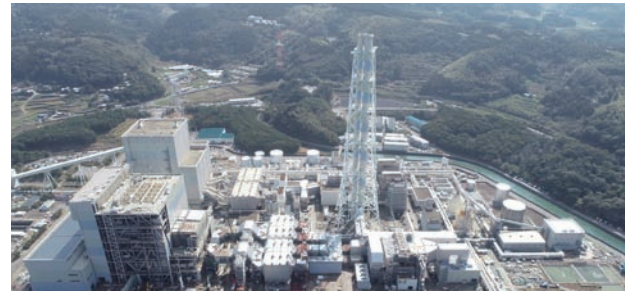
松浦発電所2号機建設状況(2019年3月現在)
