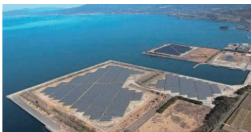
大村メガソーラー発電所
