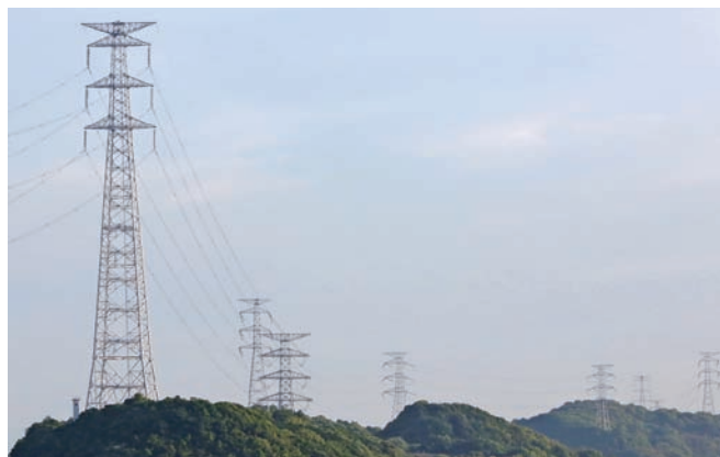
500kV 苅北火力線 (九州一高い鉄塔 [高さ195m])
