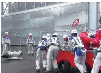
◇放水砲の設置
