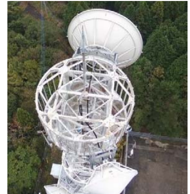
通信無線鉄塔の点検状況
