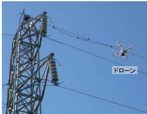
送電線の設備確認状況
