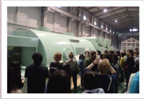
八丁原地熱発電所見学
